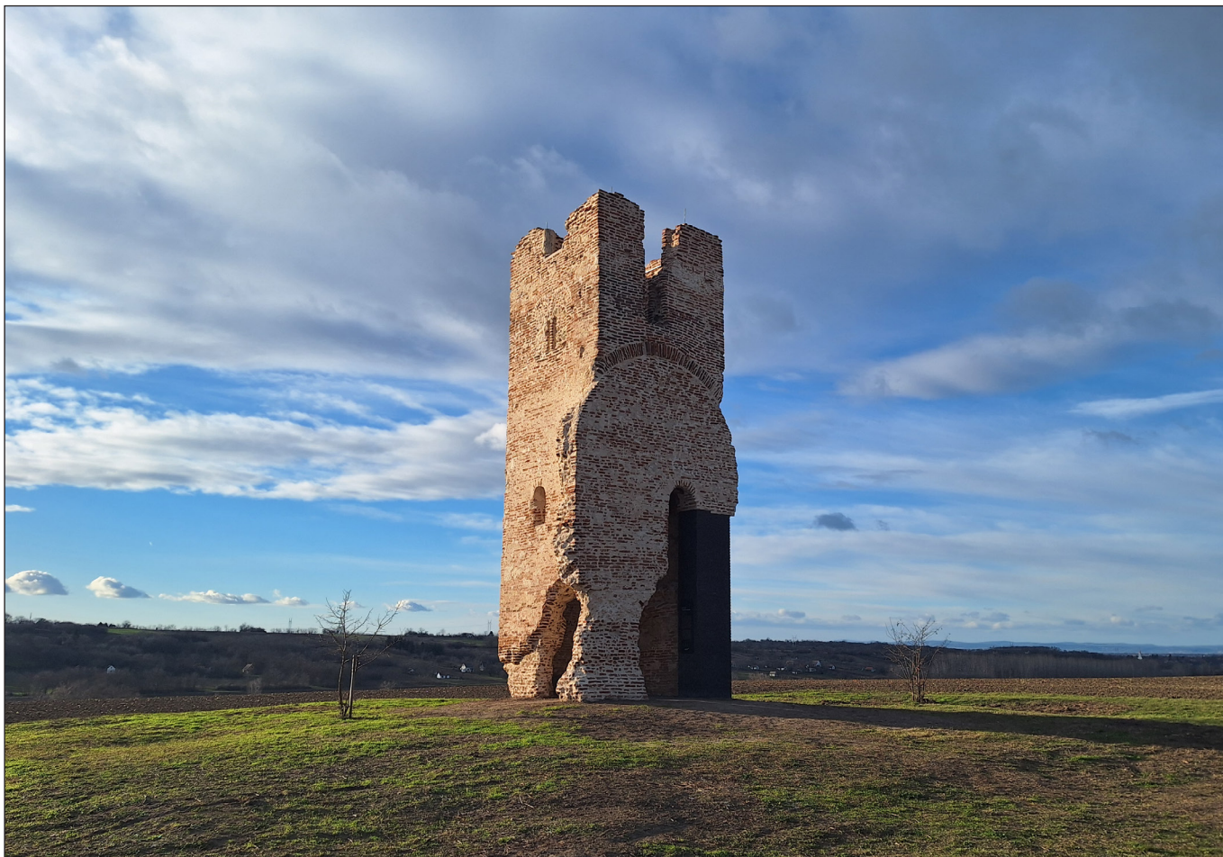
15. kép: A helyreállított és restaurátorok által konzervált torony az új sarokpillérrel
