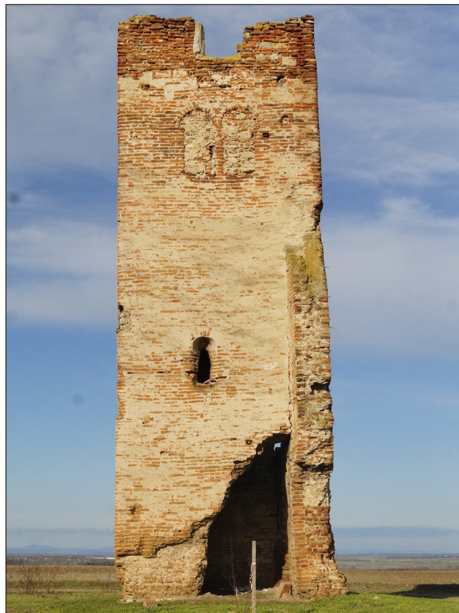
2. kép: A torony DK-i homlokzata
