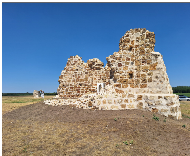
10. kép: A rom helyreállítás után – a korábbi pillérmegerősítések és új kifalazások felületkövető vékonyvakolásával (fotó: Kelemen Bálint)
