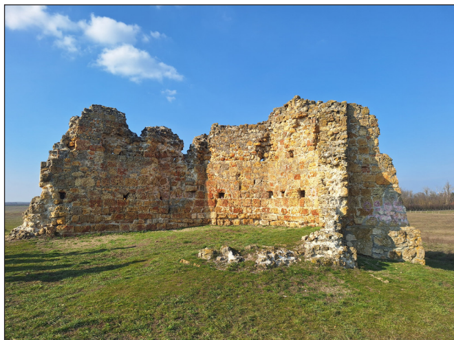
8. kép: A templom belseje helyreállítás előtt – a támpillérek 1999-es heterogén kifalazásával (fotó: Kelemen Bálint)
