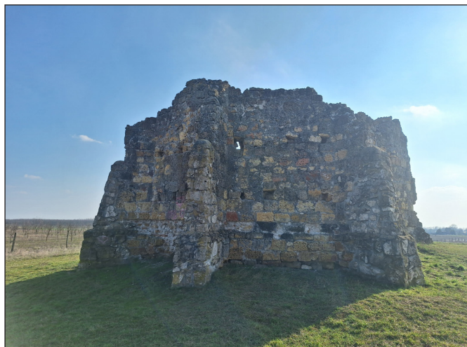
7. kép: A szentély keletről helyreállítás előtt (fotó: Kelemen Bálint)
