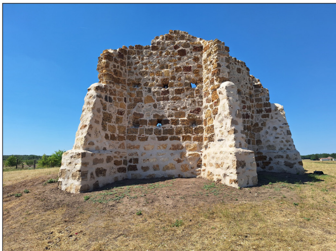
12. kép: A szentély keletről helyreállítás után – a korábbi pillérmegerősítések és új kifalazások felületkövető vékonyvakolásával (fotó: Kelemen Bálint)
