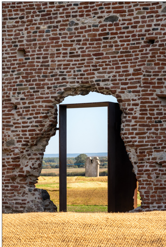
8. kép. Kapujelzés és egyben stabilizáló szerkezet (Molnár Péter, Market Építő Zrt.)
