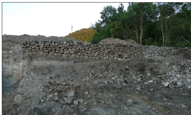
4. kép. Szárazon rakott 18. századi támfal a Sibrik-dombon (fotó: Boruzs Katalin)
