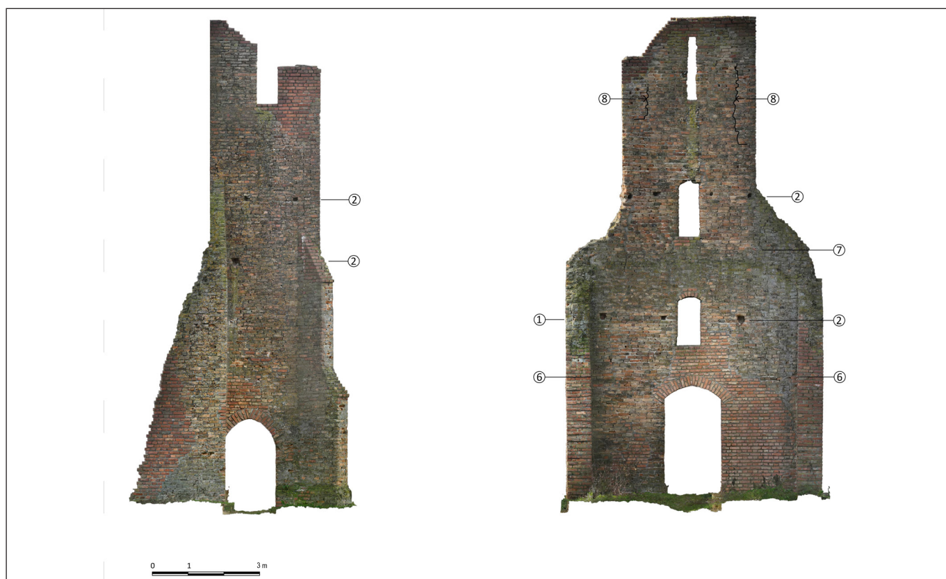
3–4. kép. A torony falnézeti rajzai, 2025 (felmérés: Kvalitron Kft., Szappanyos Tibor – KÖZTI Zrt.). 1, Ablakkáva és ablakbéllet részlete; 2, építési állvány gerendafészkei; 3, vízszintes munkahézagok a vakolatban; 4, a fal belső oldalán megfigyelhető falazási munkahézag helye; 5, vélhetőleg még az építés során elfalazott nagyobb gerendafészkek (emelőszerkezet helye?); 6, a karzathoz tartozó gerendafészkek helye a falsarokban, a két hosszfalban; 7, síkváltás – a földem helye; 8, falazási munkahézag, hozzáépítés iránya
