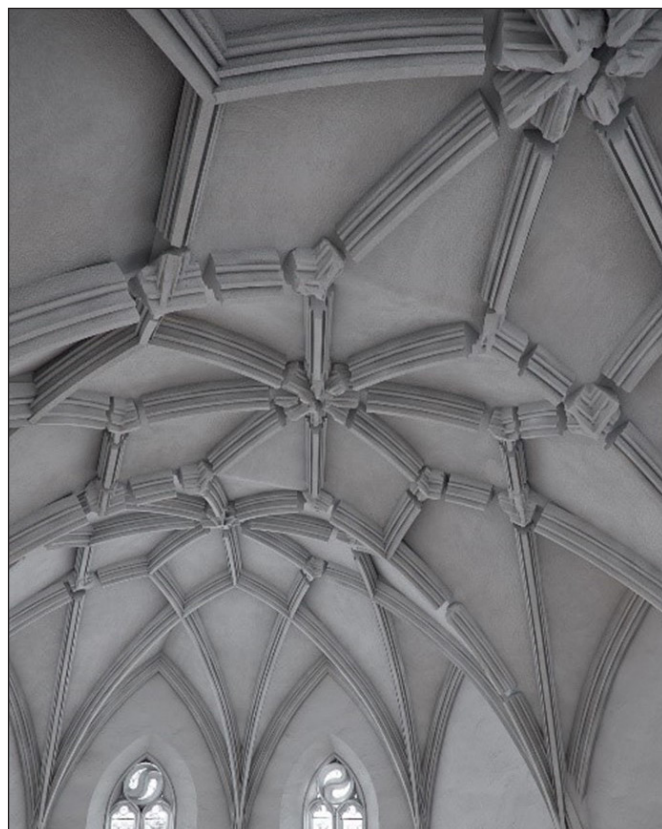
12. kép. A visegrádi ferences kolostor kápolnaboltozatának rekonstrukciója a szkennelt kőállomány felhasználásával (SziMe3D AR projekt Szőke Balázs munkája)
