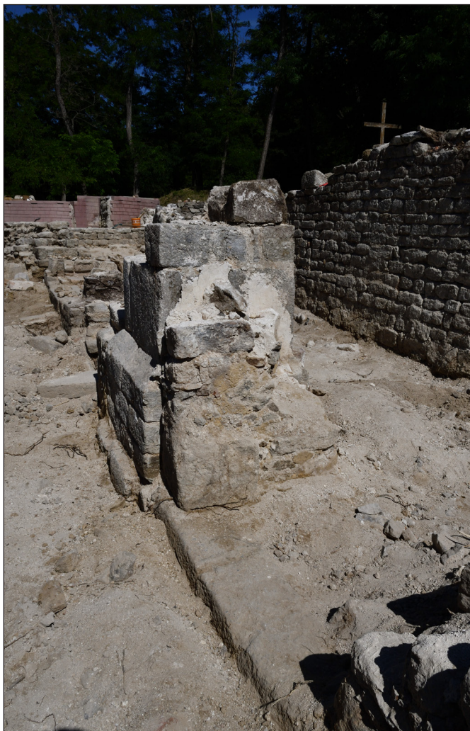
25. kép: A templom déli második pillérének utólagos megerősítése
