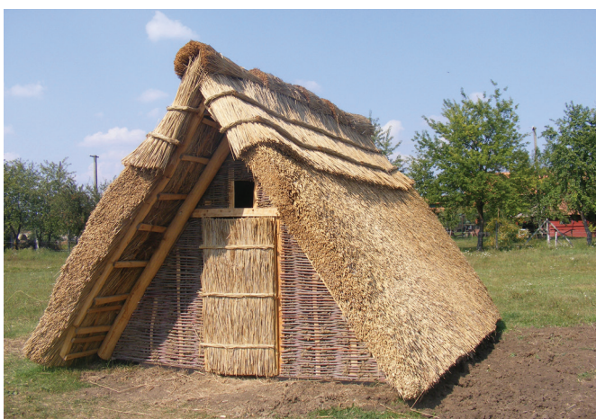
3. kép: Ollóágasos szerkezetű kunyhó rekonstrukciója Nyíregyháza-Rozsrétszőlő lelőhelyről
