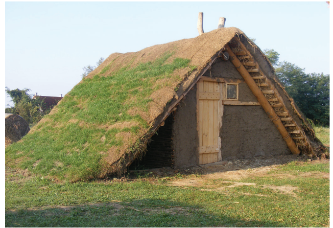
2. kép: Földbe mélyített ház rekonstrukciója Kiskunfélegyháza határából
