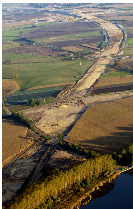
Fig. 2: The Nyíregyháza-Rozsrétszőlő-Szelkő-dűlő site in an aerial photograph (by Attila Balázs)
