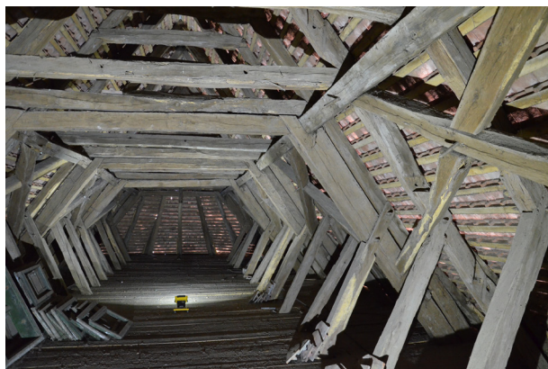
► 3. kép. A sepsikilyéni unitárius templom tetőszervezete nyugatról (fotó: Botár I. – Tóth. B.)
