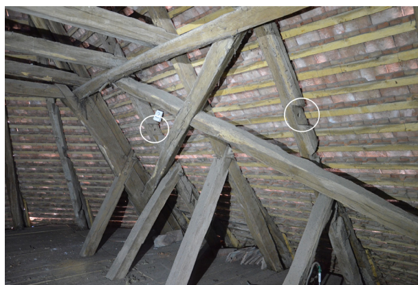
► 6. kép. Másodlagosan felhasznált szarufák a sepsikilyéni unitárius templom tetőszerkezetében (fotó: Botár I. – Tóth. B.)
