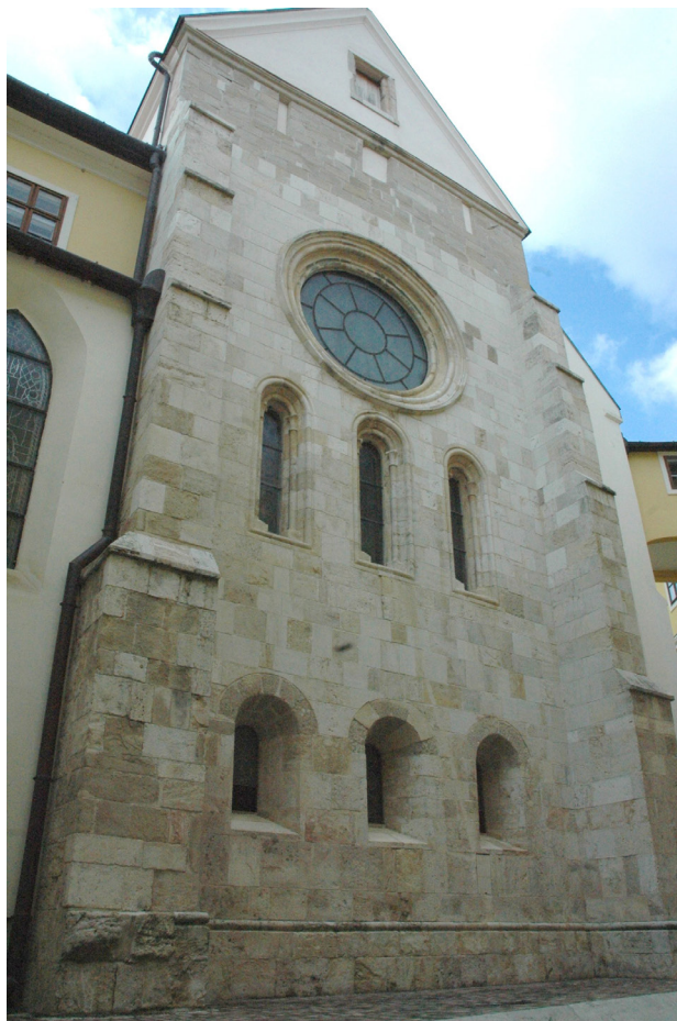
► 4. kép. A pannonhalmi bencés apátsági templom keleti homlokzata (fotó: Szakács B. Zs., 2009)
