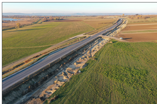
9. kép. 67-es számú főút szélesítése, Balatonlelle–Rádpusztá lelőhely feltárása, 2021. Drónfotó: Balla Krisztián
