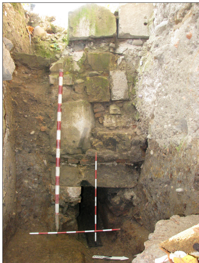
6. kép. A középső pillérek egyikének alapozása
