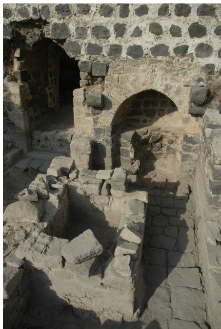
4. kép: A fürdőház B helyiségének részlete az előtérben a falazott medencével, a háttérben pedig a fülkébe épített vízmelegítő tűzhellyel (b2) (Major Balázs)
